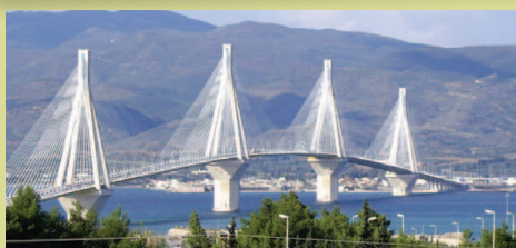
Τετάρτη 28 Σεπτεμβρίου 2016 Πέρασμα Γέφυρας Ρίου-Αντιρίου
